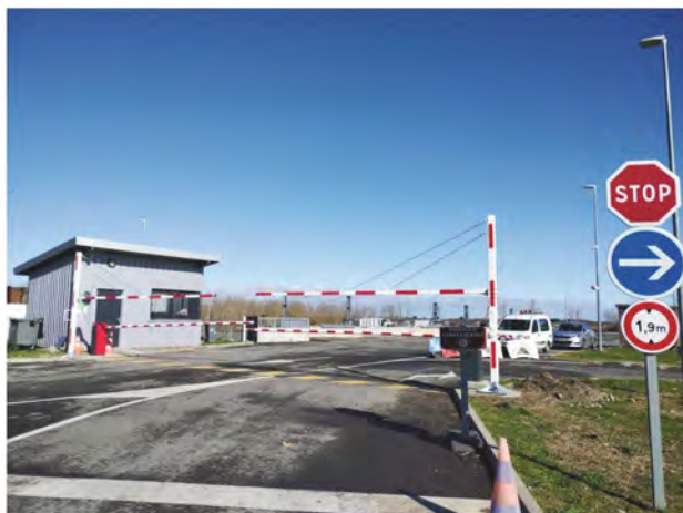
Mise en place d'un portique à la déchetterie de Carbonne
